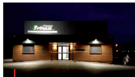
Les locaux du site de Scientrier ont été modernisés, et un showroom installé.
