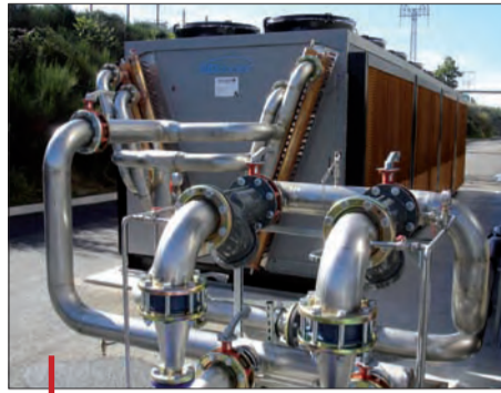
Groupe froid à fonctionnement adiabatique.
